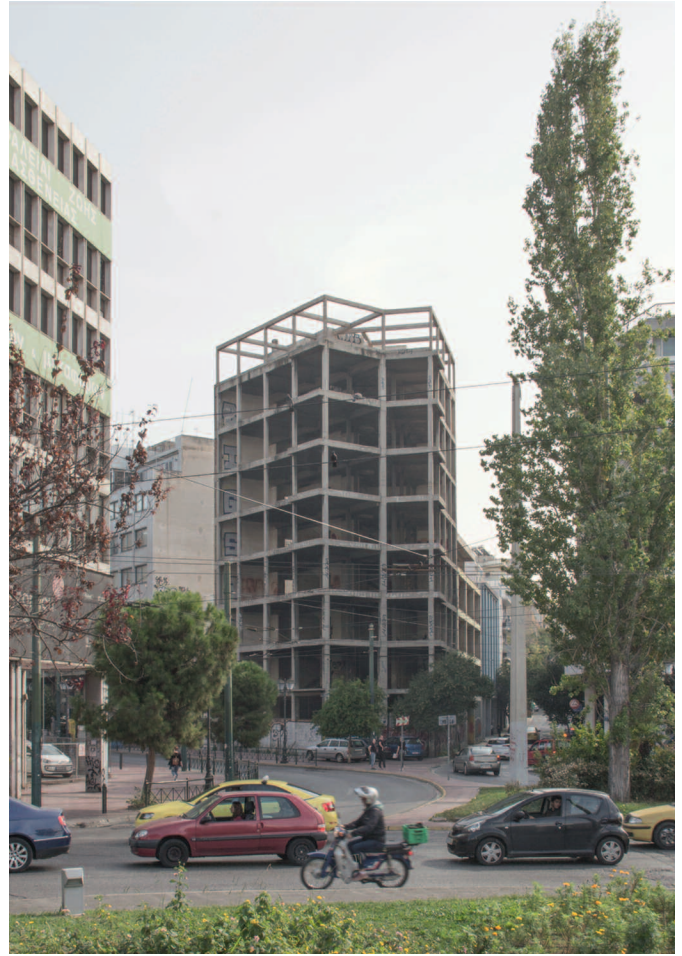
Bestandsstruktur und Kontext
