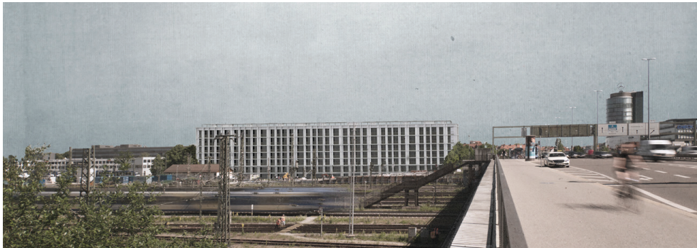
Blick über die Stammstrecke
