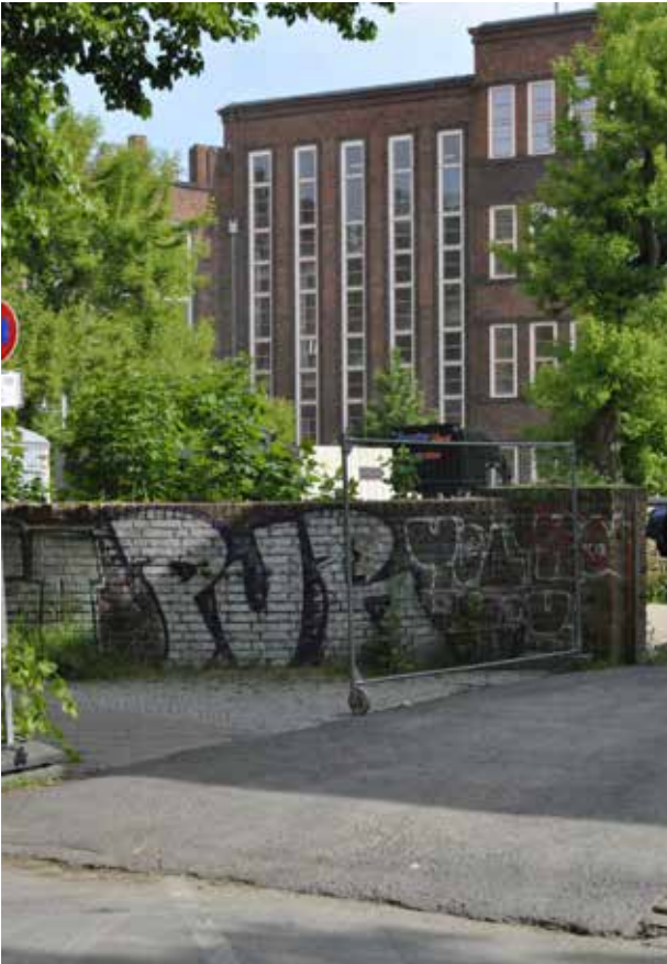
Mauerwerkspfeiler und Mauer im heutigen Zustand
