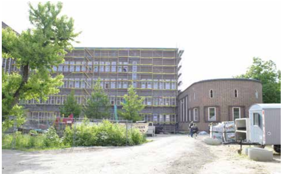
Blick vom Innenhof mit dem abgerundeten Bauteil der Aula.
