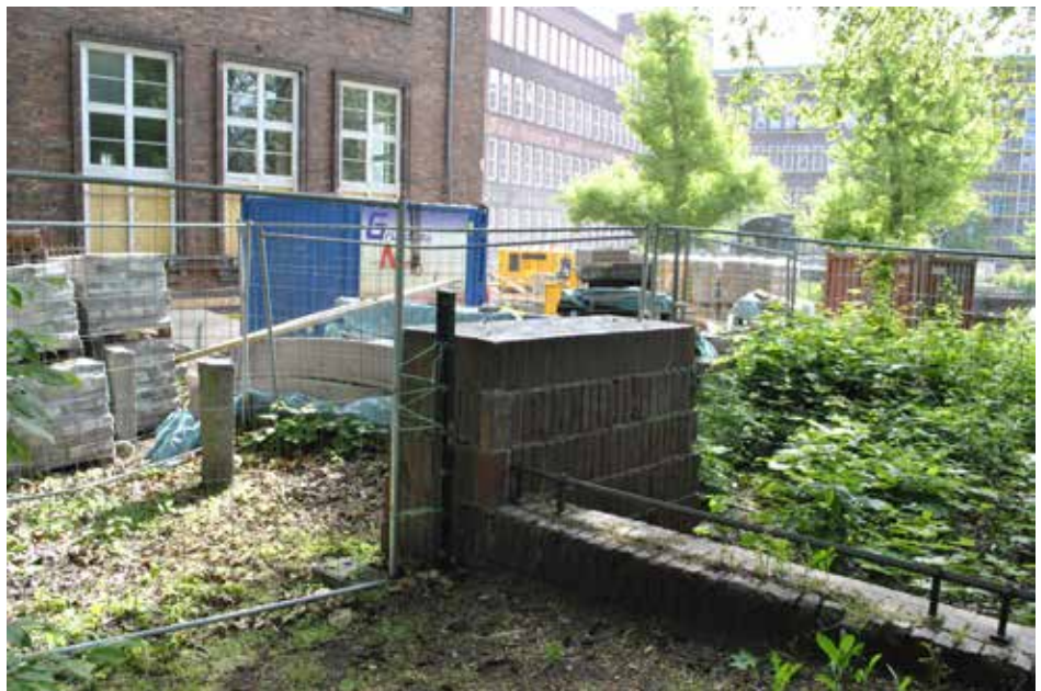
Mauerwerkspfeiler bzw. -sockel in Detailsicht
