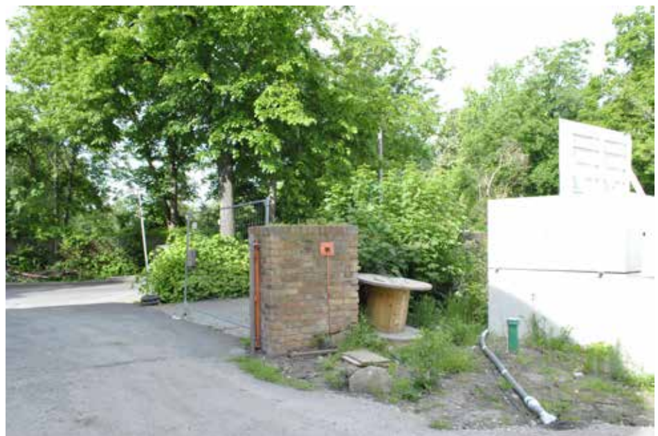
Mauerwerkspfeiler bzw. -sockel in Detailsicht
