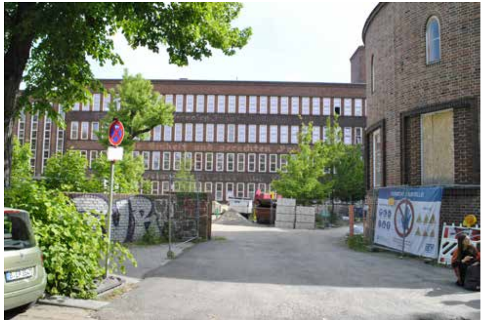
Eingangstor Amalienstraße mit Mauerwerkspfeiler (links) und Aula (rechts)
