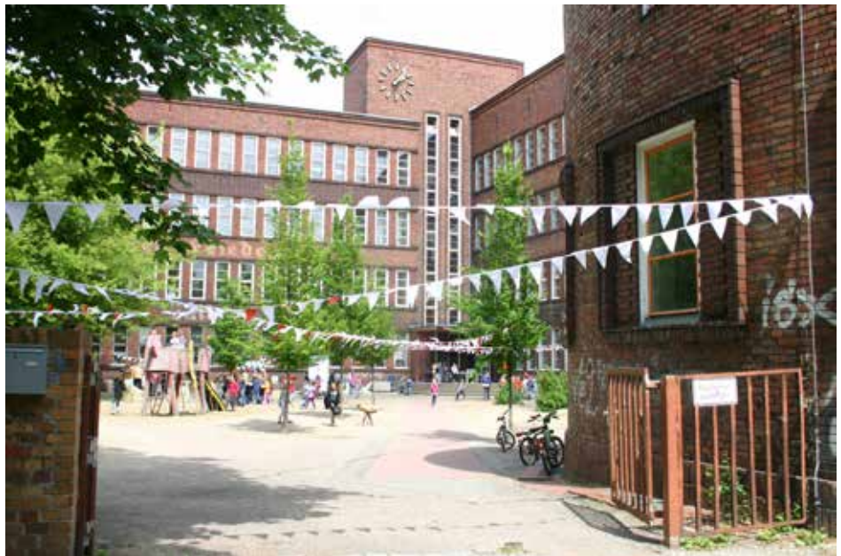
Der Innenhof der Grundschule am Weißen See vor dem Beginn der Instandsetzungsarbeiten.
