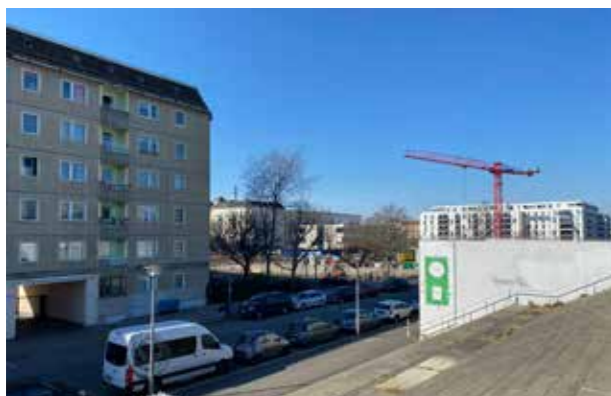
Blick auf die Baustelle der 48. Grundschule
