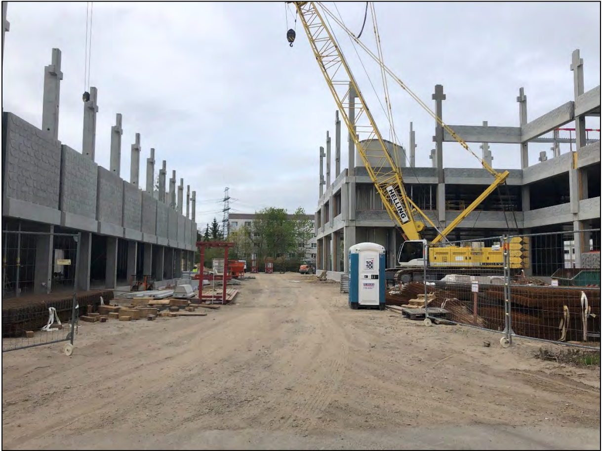
Ansicht Vorplatz zwischen Sporthalle (links) und Grundschulgebäude (rechts) von der Grundstücksgrenze an der Ernst-Ludwig-Heim-Straße
