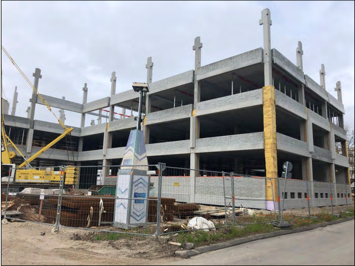
Ansicht Grundschulgebäude von der Grundstücksgrenze an der Ernst-Ludwig-Heim-Straße, auf Höhe des Gehwegs zum Haupteingang
