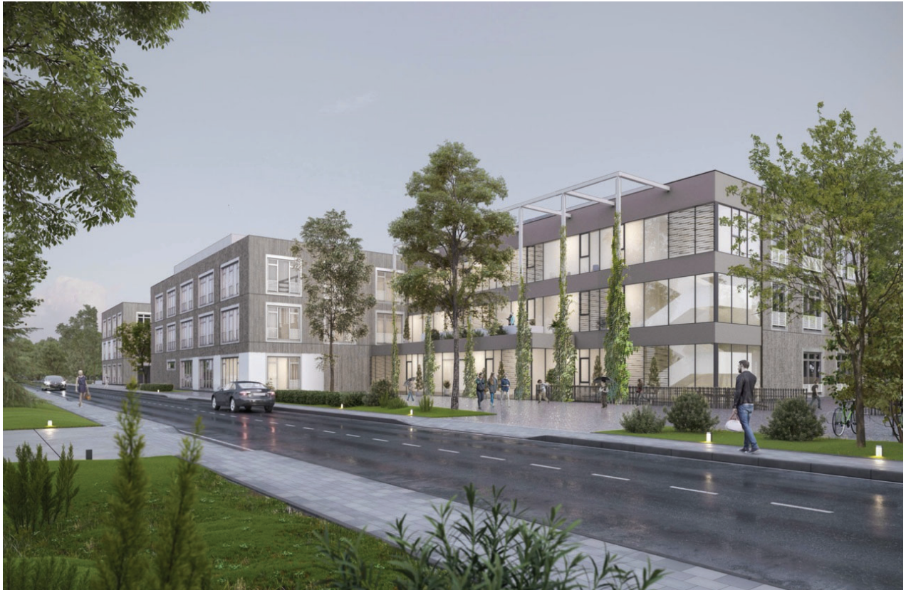
Bearbeitungsbereich 3 © Böge Lindner K2 Architekten
