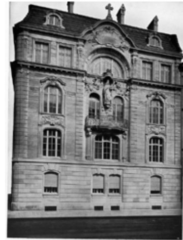
Barocke Stifassade des Probsteigebäudes um 1900
