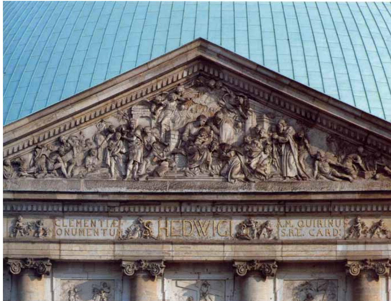
Historische Dacheindeckung vor der Sanierung
