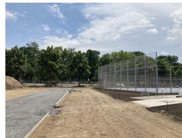
Fotos der Baustelle
