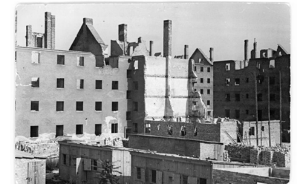
Blick auf die Ruinen der sogenannten „toten Stadt“ an der Kniprodestraße nach Kriegszerstörungen
