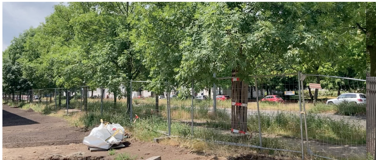
Blick vom neuen Verbindungsweg auf die Kniprodstraße mit der Eschenallee
