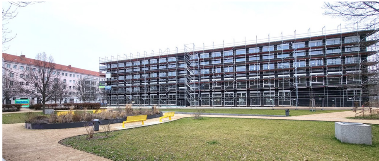
Schulgebäude im Rohbau, im Vordergrund der neugestaltete Lenné-Meyer Garten
