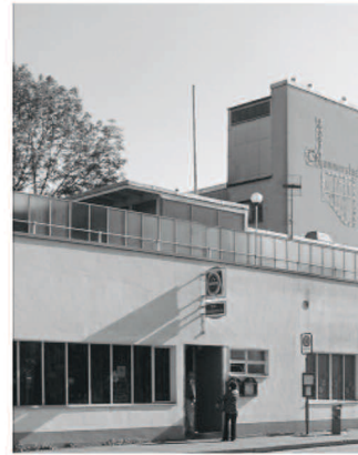
Kontext Fotografie Waschhaus Dammerstocksiedlung
