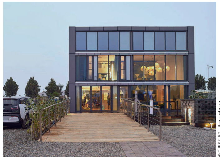
Das fertige C-House
